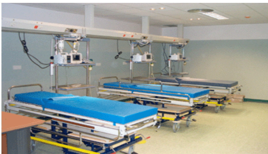
Figura 3. Consulta de críticos del Hospital Reina Sofía
